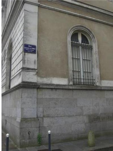
La façade principale se trouve au nord, elle donne sur le fleuve. Le matériau utilisé est la pierre de taille, du tuffeau. La pierre calcaire se retrouve sur chaque angle de l'édifice et sert d'entourage aux fenêtres sur toutes les façades.
