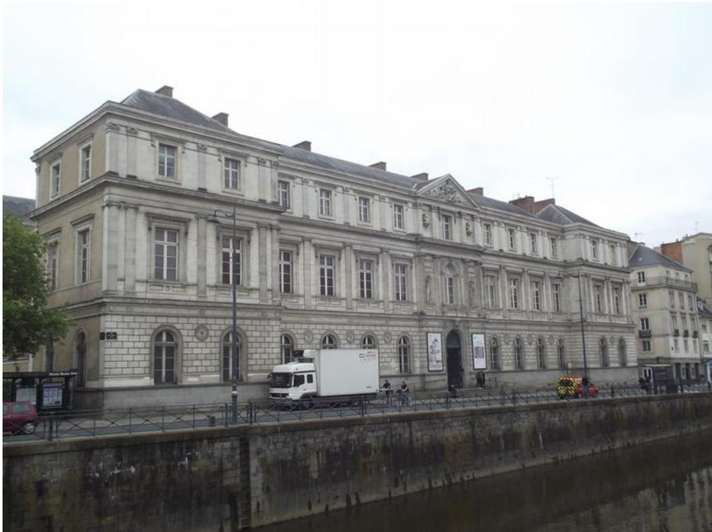
Le plan de la construction est rectangulaire avec à chaque angle, un pavillon. Les ailes du bâtiment entourent une cour centrale à la manière d'un cloître surmontée de deux niveaux. L'ensemble de la construction repose sur un soubassement en granit. Le toit est en ardoise.
