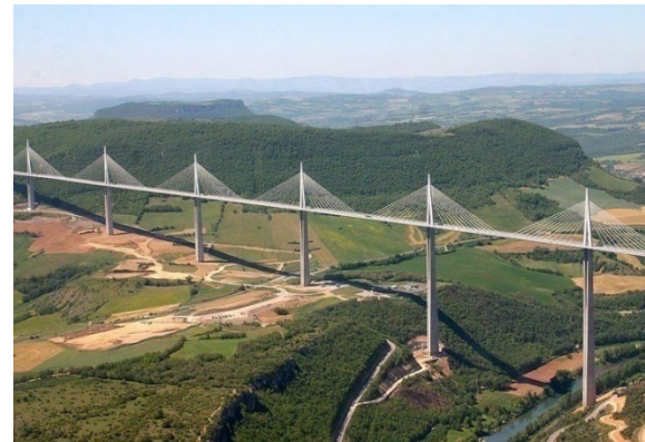
Viaduc de Millau
